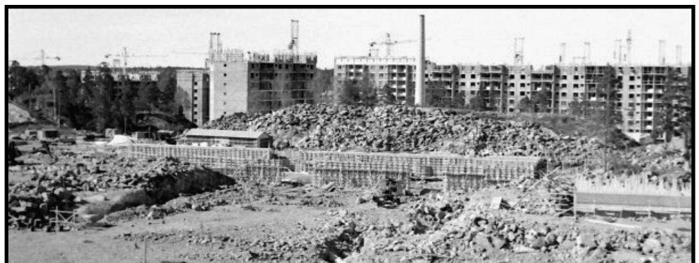
Byggandet av centrum och apotekshuset
